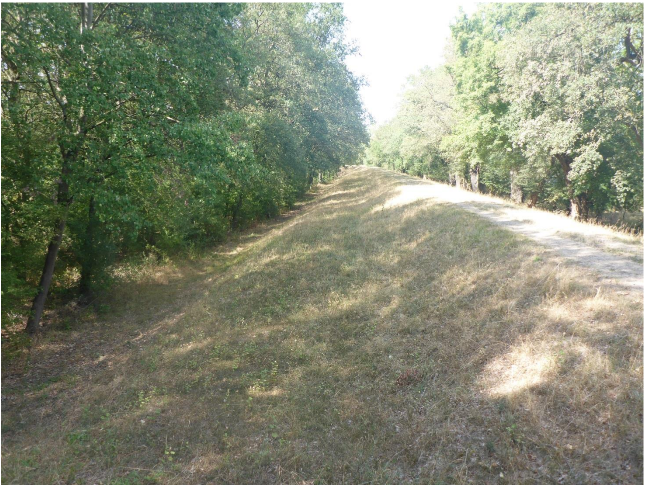
Abbildung 6: Deich Schöpfwerk bis Deichrückverlegung
