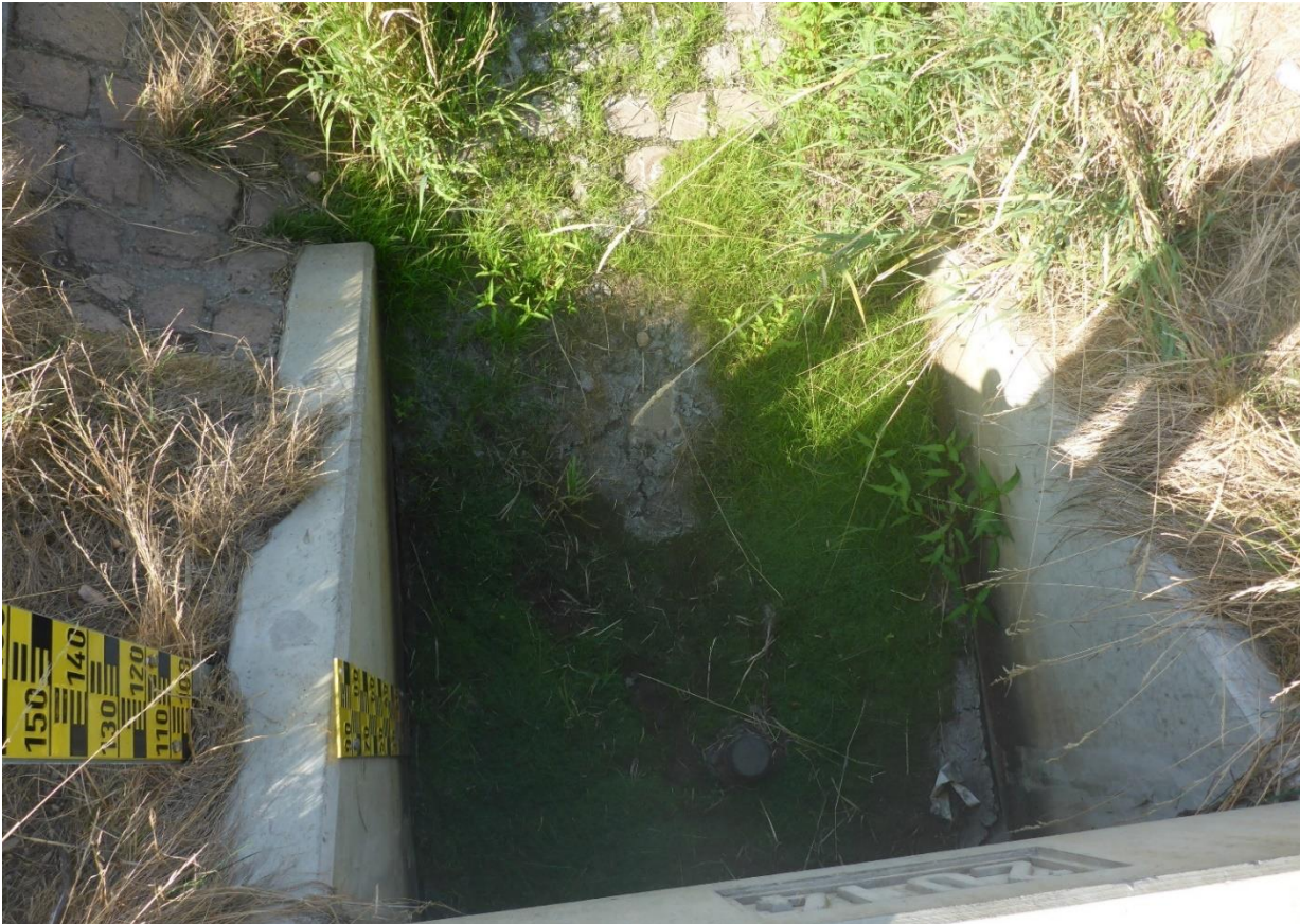
Abbildung 12 Durchlass Mühlgraben mit Pegellatte
