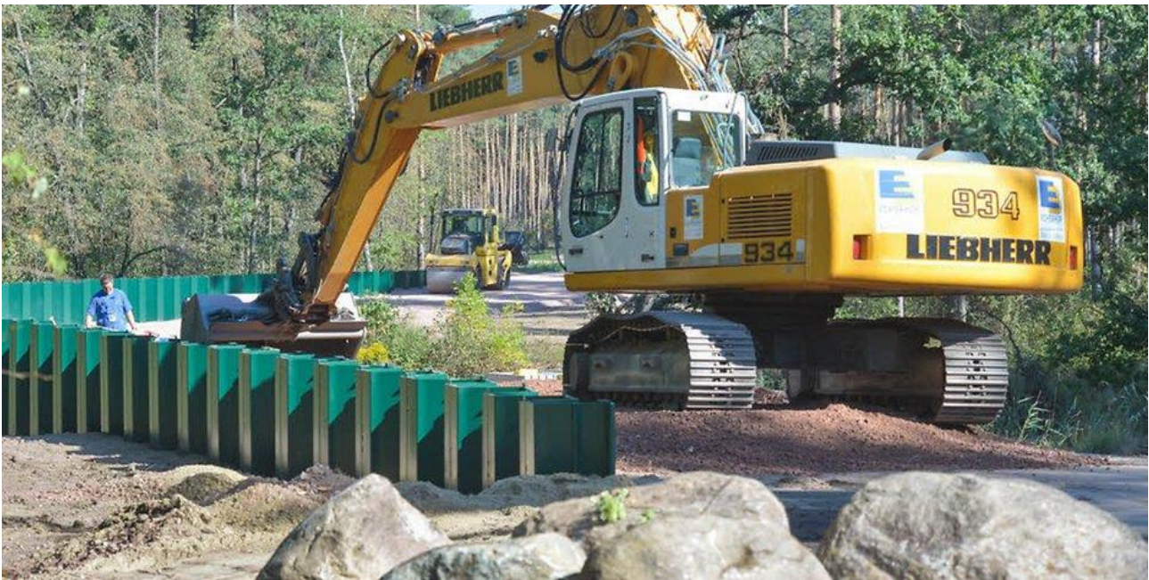
Abbildung 2 Deichbau Mutter Storm, Spundwand Deich-km 1+200 bis 1+300
