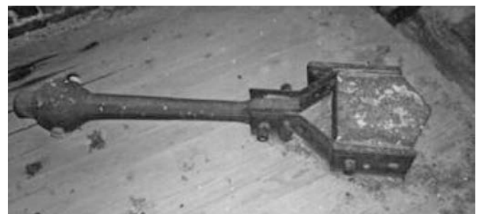
Gekröpftes Glockenjoch im Süd-Turm und Klöppel der großen Glocke von 1917
