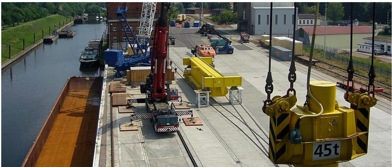
Blick auf den Schwergutverladebereich im Hafen Aken
