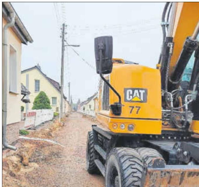
Im Zusammenhang mit dem weiteren Straßenbau ist vorgesehen, die vorhandene Straßenbeleuchtungsanlage und die zugehörigen Kabel ebenfalls zu erneuern. In Zusammenarbeit mit dem Stromversorger ist im Vorfeld des Straßenbaus die Verlegung der bisherigen Freileitungen in die Erde vorgesehen. Mit folgenden Leistungen wird der Straßenkomplex hochwertig saniert:
