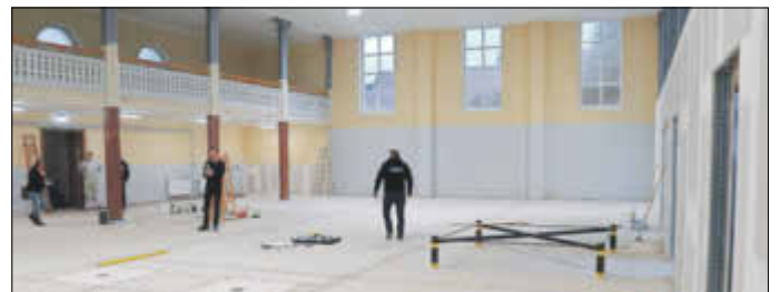
Der fertige Estrich-Fußboden kurz vor dem Verlegen des Sportbodenbelages.
