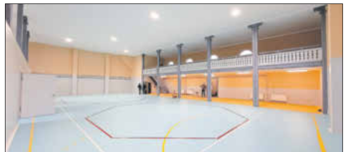
Der fertige Estrich-Fußboden kurz vor dem Verlegen des Sportbodenbelages.
