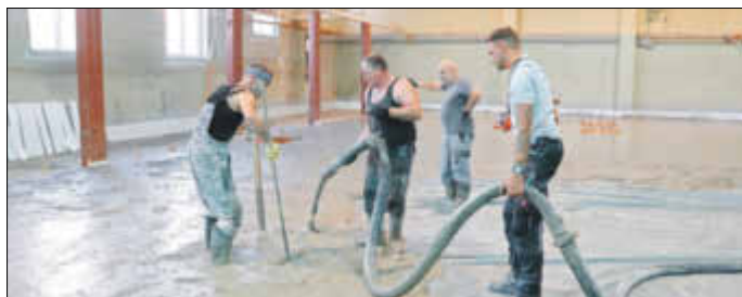
Gießen der Bodenplatte für den neuen Sportboden
