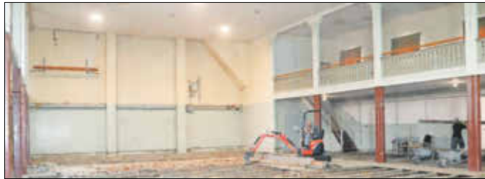
Mitarbeiter der Udo Endt GmbH nehmen mit einem Minibagger den alten Parkettfußboden auf
