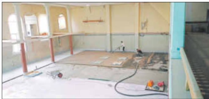
Mitarbeiter der Udo Endt GmbH nehmen mit einem Minibagger den alten Parkettfußboden auf
