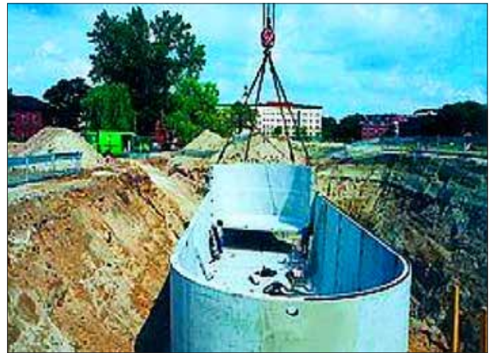
Abbildung 3: Regenwasserrückhaltebecken, Firma Mall (Coswig, Anhalt)
