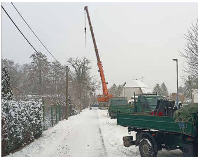
Kranunterstützte Gefahrbaumfällung an der Jugendbegegnungsstätte
